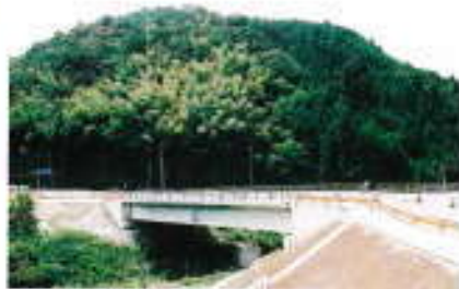
新埤橋(単跨PCコンボ桁橋)
