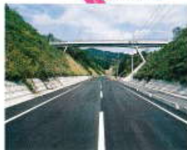
麻生田トンネルへ向う直線部
