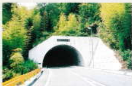
中山トンネル 海士路町側入口
