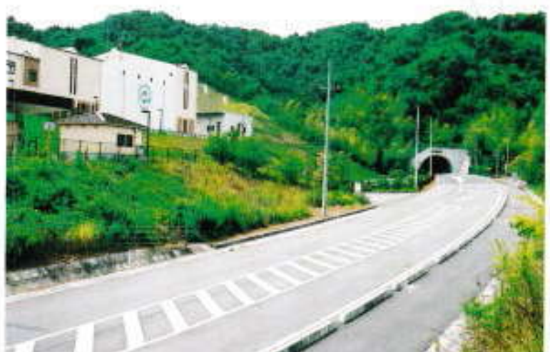
岩国市リサイクルプラザ付近
