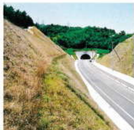
麻生田トンネルの海土路町側入口
